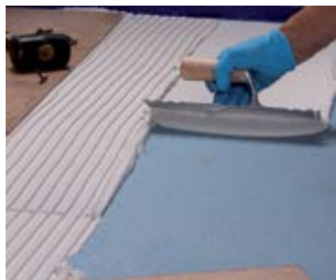
Burkolólapok ragasztása a Mapelastic AquaDefense Zero-ra
