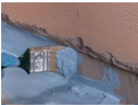
A Mapelastic AquaDefense Zero felhordása ecsettel a fal-padló csatlakozáshoz a Mapeband Easy elhelyezése előtt
